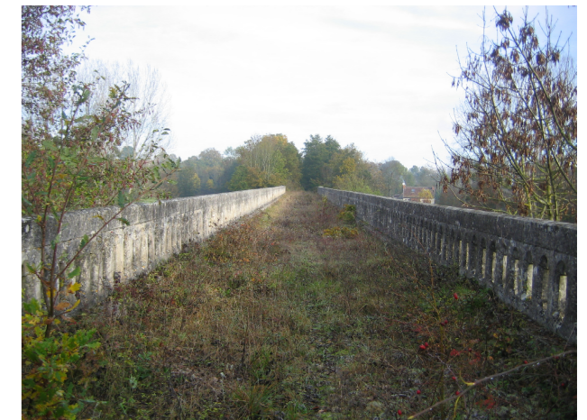
Le pont de l'ancienne voie ferrée
