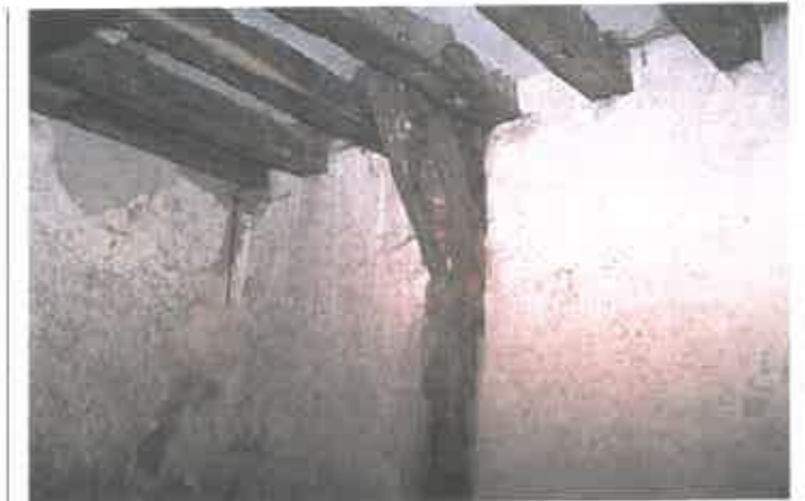
La Bergelière, structure bois
