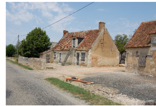
Bâtiments en retrait de la D20
