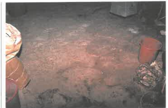
La Bergelière, dalles au sol
