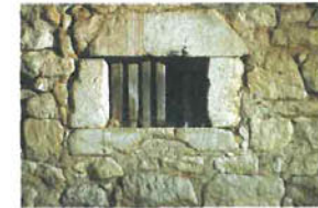
Les fenêtres sont petites et peu nombreuses. Elles étaient closes par des barreaux de bois.
