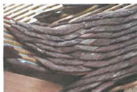
L'étanchéité est réalisée en croisant les rangées de tuiles. Les couvreurs choisissent spécialement des tuiles torsées, pour les adapter au mieux à la forme de la noue.
