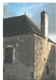
Cheminée en pierre, implantée le long d'une croupe.
