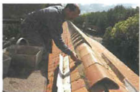
L'étanchéité est assurée par des boudins de mortier, formant des crêtes, qu'on appelle "pigeons", et des embarrures.
