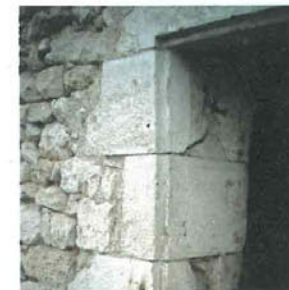
Les fenêtres sont petites et peu nombreuses. Elles étaient closes par des barreaux de bois.
