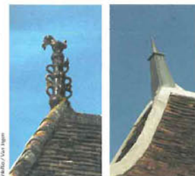
Les épis sont de formes très variées. Ils mettent parfois en scène des coqs ou des oiseaux, encadrés d'anses. Ils peuvent aussi, plus modestement, se limiter à des pots de terre cuite retournés ou à des protections en zinc.
