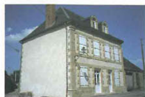
A Prissac, la structure des maisons du bourg est soulignée par des chaînages de grès ocre.
