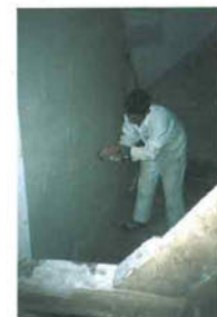
Un enduit lissé, suivant la surface du mur, est doux au toucher et à l'oeil.
