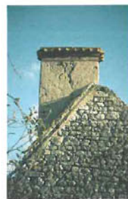
Un rang de briques du couronnement est posé en quinconce.
