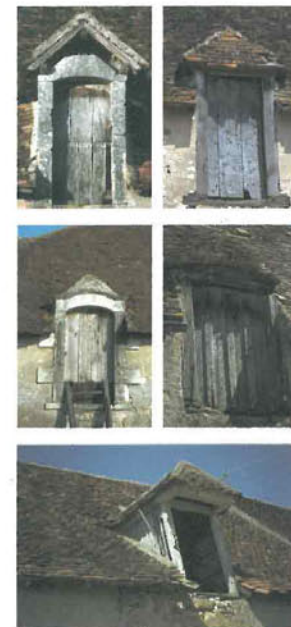
Elles sont couvertes d'un toit à deux pentes ou à croupe (en bâtière ou à la capucine), parfois à fronton, surtout dans les bourgs.
